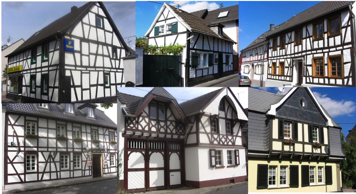
Restaurierte Fachwerkbauten, die vom Leben im „alten“ Bergheim erzählen können
