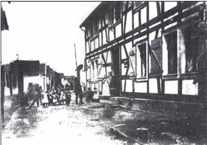
Das Geschäftshaus Schell um 1907. Ganz recht gerade noch zu sehen - die Pumpe.
