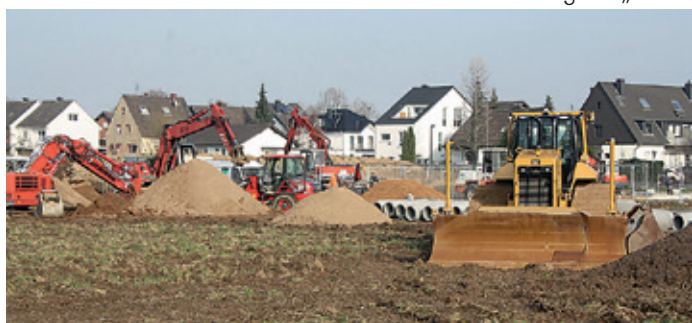
Der Bau der städtischen Kita hat bereits begonnen.
