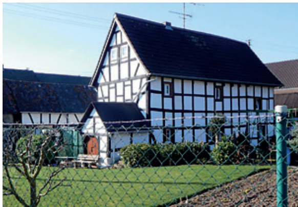
Blick auf den Junkershof vom Sträßchen „Am Zerresgarten“. Das Gelände grenzt mit einem alten Scheunentrakt an die Siegstraße.
